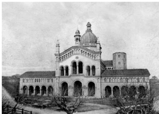
Anno 1910. Il campanile del Santuario in costruzione (1903 - 1913)
