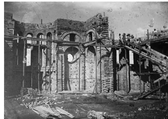
Anno 1894. Muratori al lavoro per la costruzione del Santuario.
