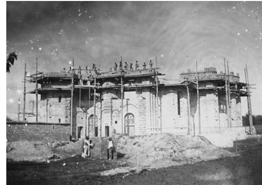
Gennaio 1894. Stato dei lavori di costruzione del Santuario (1892 - 1905)
